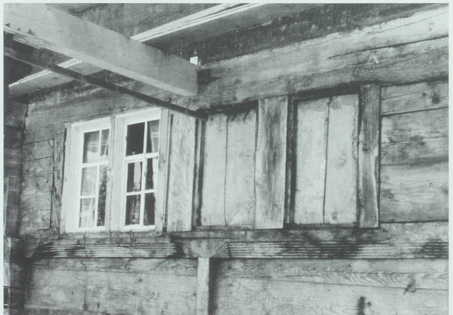
Zwei zugeschaltete Fenster der Nordwestfront werden wieder geöffnet. Bild 1985 (ebenfalls das Bild rechts): Franz Wildhaber, Flums.
