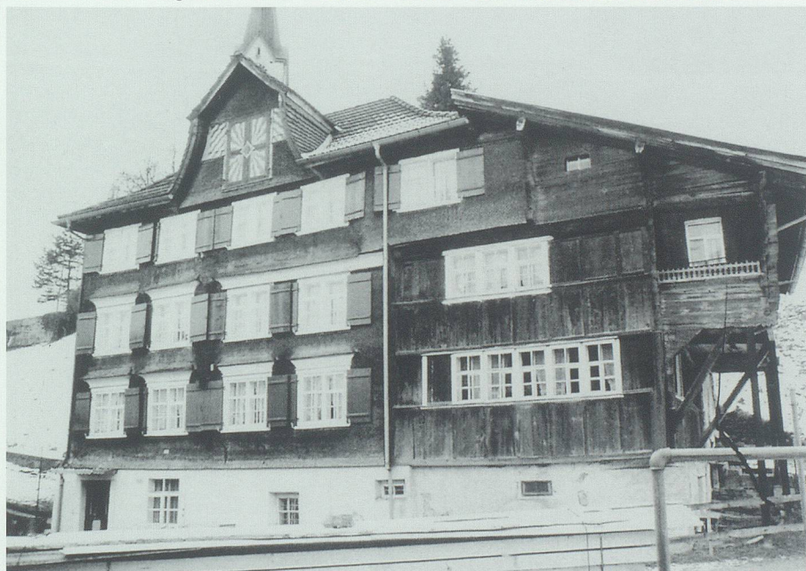
Das alte, gestemmte Täfer mit den Zugläden aus dem frühen 18. Jahrhun- dert hat man zugunsten des älteren Stricks 1985 entfernt. Bild 1985.
