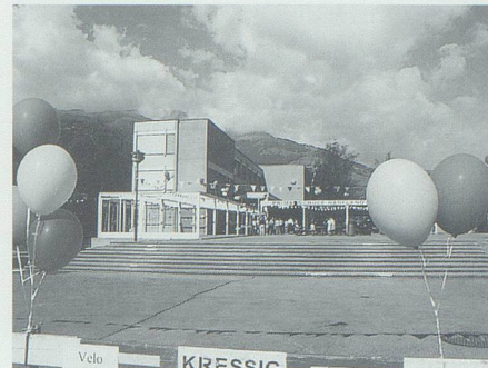
21. Juni: Das Buchser Primarschulhaus Hanfland wird nach Renovations- und Aufstockungsarbeiten wieder eingeweiht.
