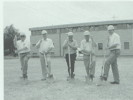
16. Juli: In Haag ist Spatenstich für die erste Bauetappe des neuen Zeitungsdruckzentrums der Südostschweiz Partner AG.
