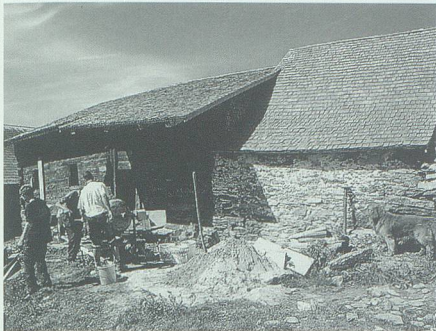
10. Juni: An die Sanierung des alten Walser Hauses in Hinterpalfris leisten auch mehrere Berufsschulklassen einen wertvollen Beitrag.
