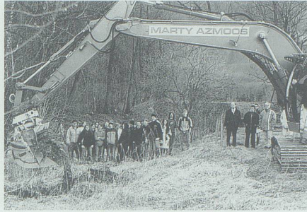
12. März: In der Cholau bei Weite werden die Arbeiten zur Schaffung eines «Familien- und Naturparadieses» aufgenommen.
