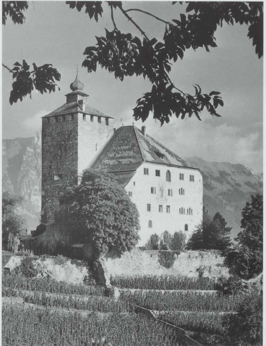
Schloss Werdenberg um 1950. Das an der Ostfassade erkennbare Bild des Glarner Schutzheiligen St. Fridolin wurde bei der Aussenrestaurierung von 1977/78 entfernt und durch das Wappen der Grafen von Werdenberg ersetzt.
