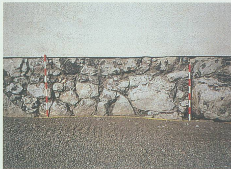
Südmauer des Kirchenschiffs mit der Verlängerung des 17. Jahrhunderts und der alten Südwestecke des Baus von kurz vor 1512 (rechts).
