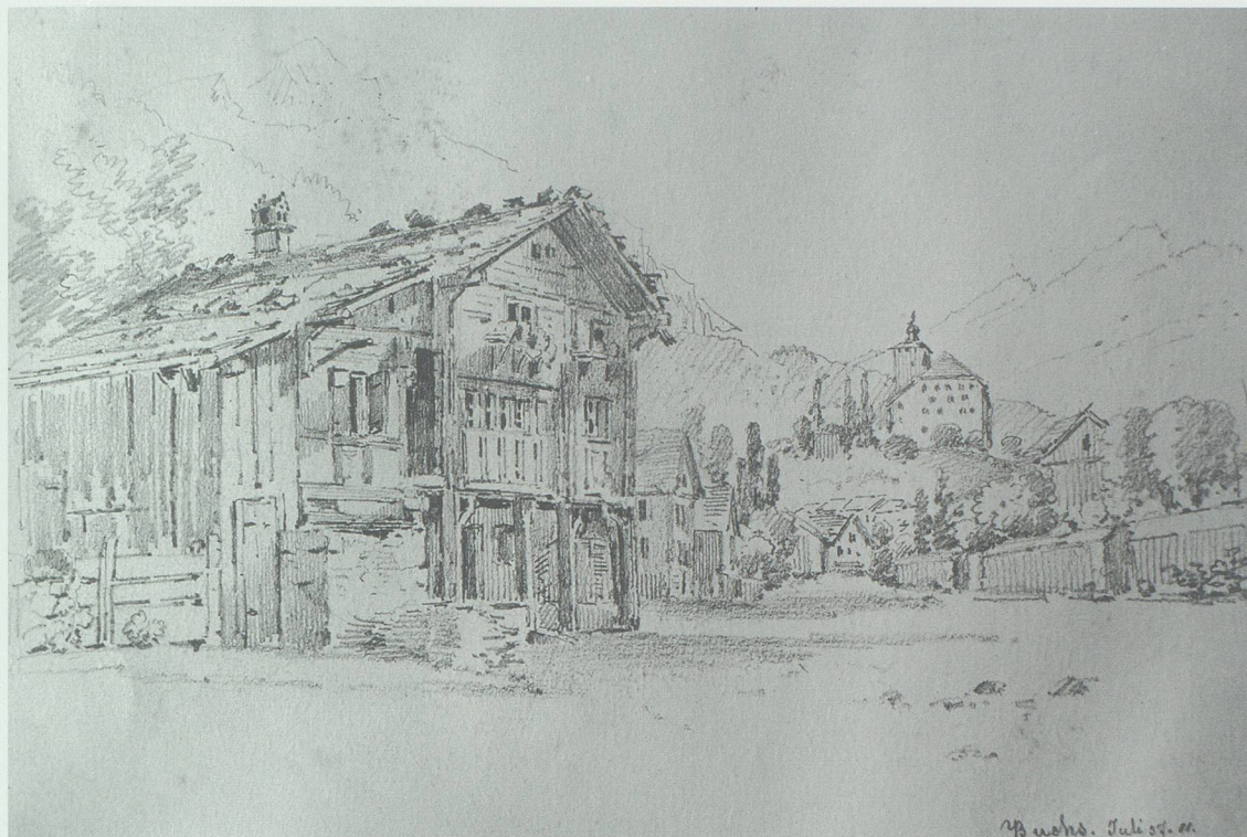
Die 1840 begradigte Landstrasse, die nachmalige St.Gallerstrasse: Auch 18 Jahre nach dem Unglück sind noch nicht alle Häuser mit Ziegeln bedeckt. Zeichnung von Johann Jacob Rietmann, Juli 1857. In Privatbesitz
