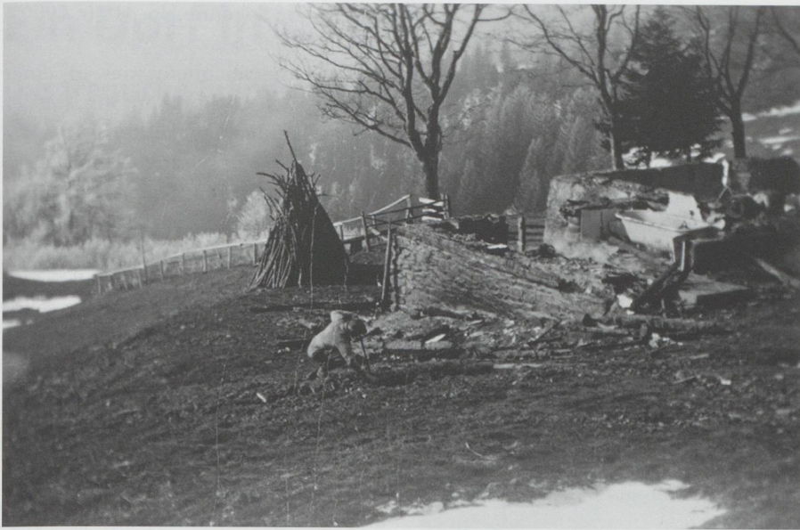
Der östliche Teil der Brandruine mit «Bad und Dynamo». Die verkohlten Schindeln weisen auf die Bisenlage beim Brandausbruch hin. Bild aufgenommen von Feuerwehrkommandant Fritz Sulser. Im Staatsarchiv St.Gallen
