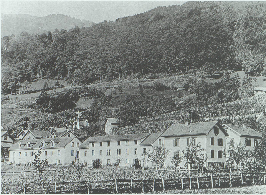
Arbeiterwohnhäuser («Tschinggehüser») der Weberei Azmoos um 1900.
