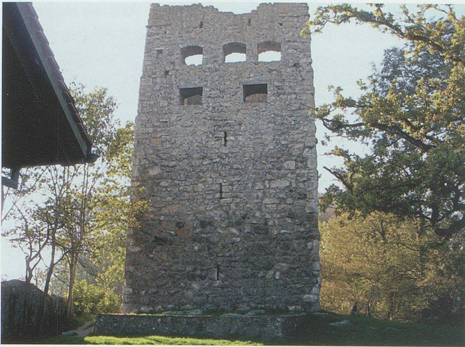
Abb. 43: Die Burg Blatten bei Oberriet diente dem Obervogt des Abtes von St.Gallen bis 1798 als Wohnsitz. In den Auseinandersetzungen zwischen Franzosen und Österreichern im Jahr 1799 wurde sie zerstört.
