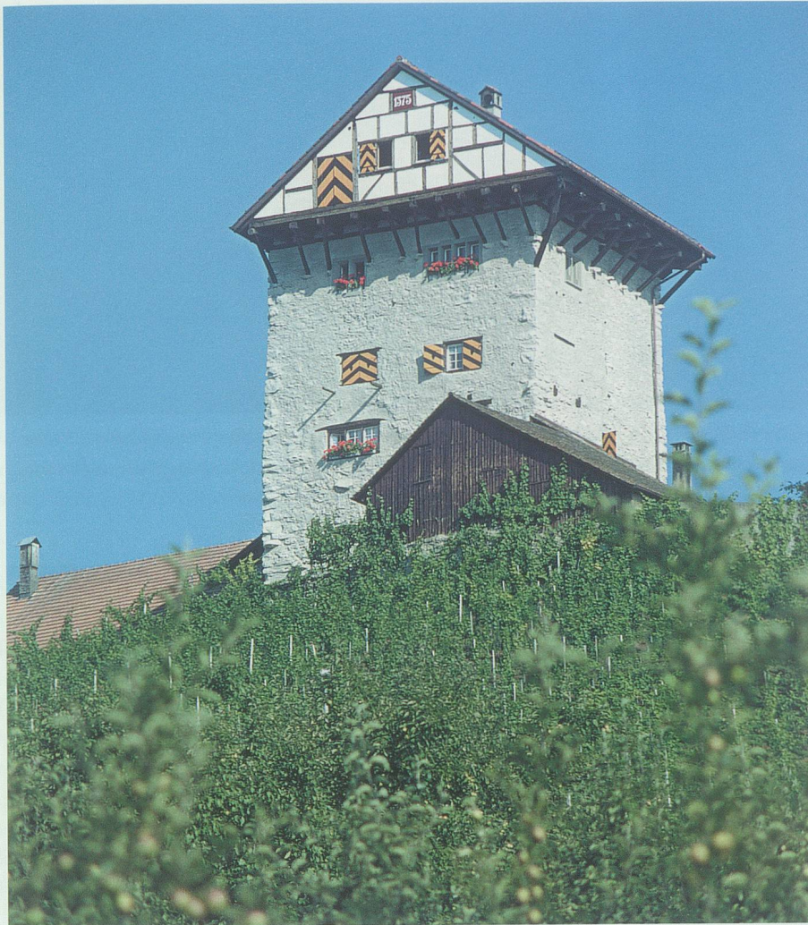
Abb. 20: Beim Wohnturm von Neu-Altstätten ist der vorkragende, hölzerne Oberboden erhalten, wie er auf vielen Burgen bestand. Die grossen Fenster im Turmsockel wurden später herausgebrochen.
