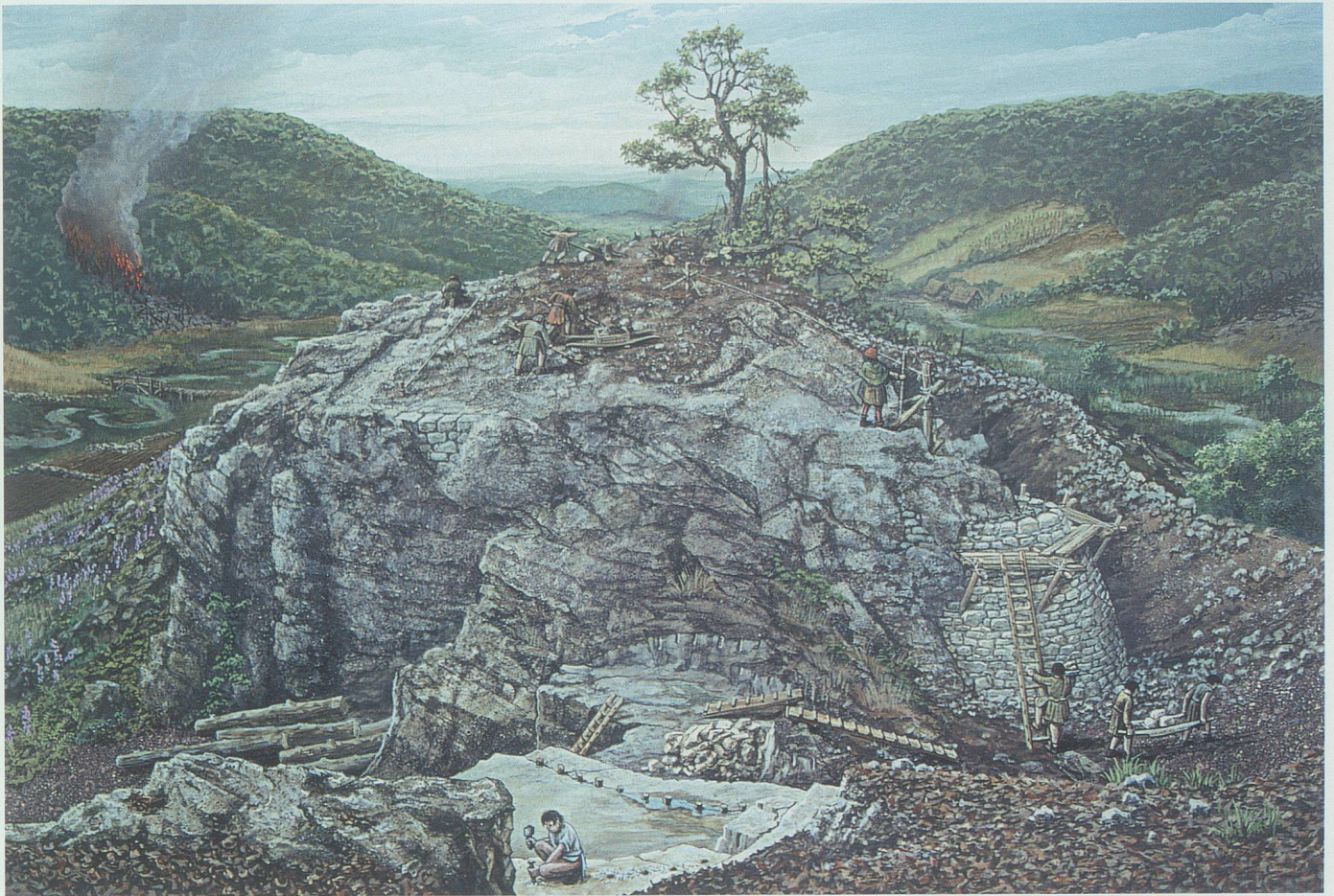
Abb. 11: Der Illustrator Jörg Müller hat am Beispiel der Burg Radegg SH die Arbeiten festgehalten, die vor dem Bau einer Burg erledigt werden mussten. Im Burggraben schlägt ein Arbeiter Löcher in den Fels. Dort hinein werden Hölzer gesteckt, die mit Wasser zum Schwellen gebracht werden und so die Steinblöcke absprengen.
