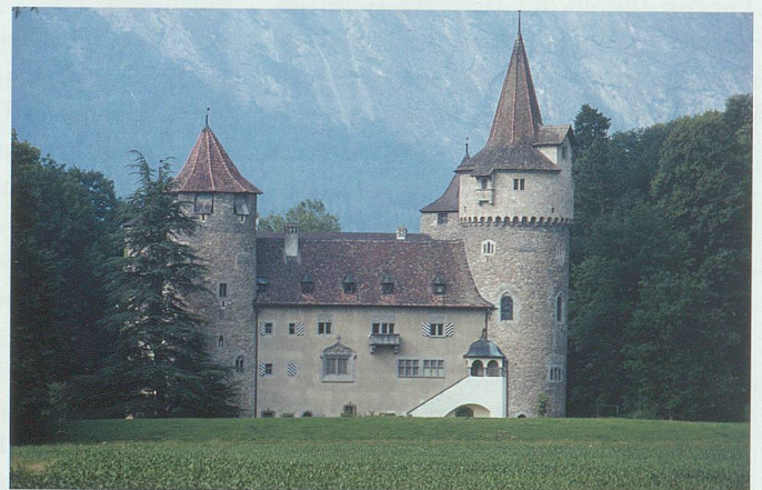
Abb. 26: Die um 1300 erbaute Vierecksanlage Marschlins (Igls GR) geht auf savoyische Vorbilder zurück. Sie weist vier runde Ecktürme auf und war ursprünglich von einem Wassergraben umgeben.
