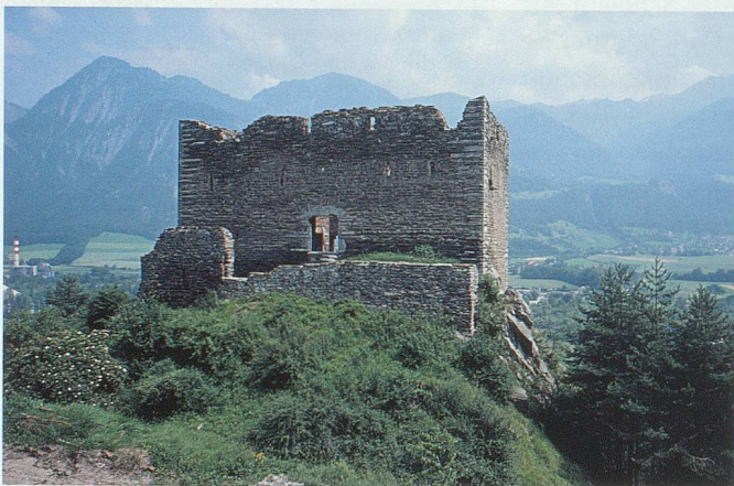
Abb. 25: Beim Bau der Neuburg (Untervaz GR) zu Beginn des 14. Jahrhunderts verzichtete man auf einen Wehrturm. Ein Zwinger schützte den Eingang zum wehrhaften Palas.
