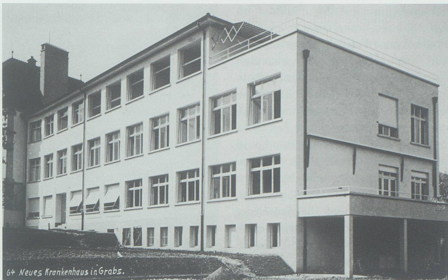
Blick auf die Fassade des ersten Erweiterungsbaus (Aufnahme von 1939). Im Parterre lagen Räume für Privatpatienten, im ersten Stock befand sich die geburtshilfliche Abteilung, im zweiten Stock wurden Tuberkulosekranke untergebracht. Im Archiv Hansruedi Rohrer, Buchs
