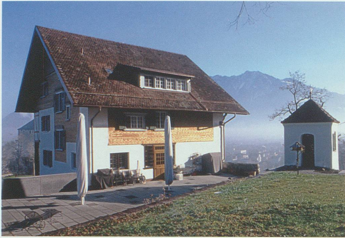
Ansicht von Nordwesten, 2006. Foto kant. Denkmalpflege
