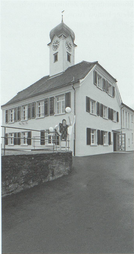
2. Juni: Das bald 200 Jahre alte Schulhaus Büel in Oberschan erstrahlt nach der Renovation mit frischem Charme.
