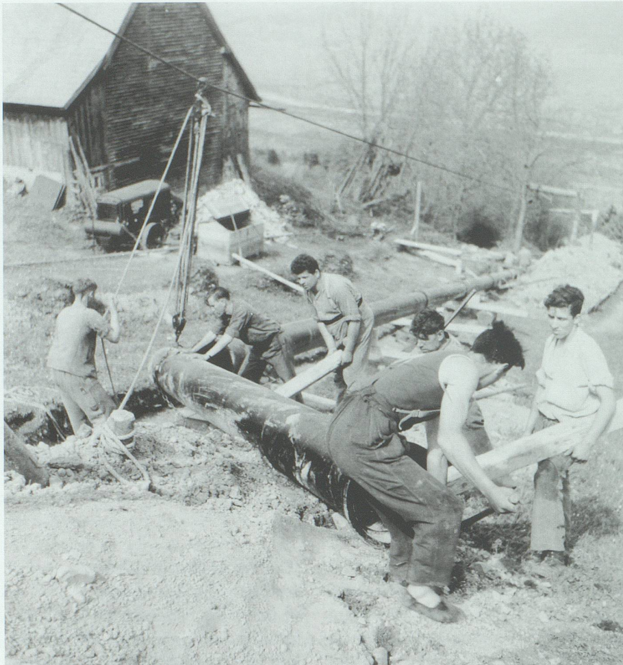
Die Energieknappheit während des Zweiten Weltkriegs bewog das EWB 1942 zu einem Ausbau der Produktionskapazitäten mittels einer Wasserfassung im Tobelbach, dem Bau eines Ausgleichsweihers und einer neuen Druckleitung (Bild). Aufnahme vom 20. Mai 1942. Archiv Hansruedi Rohrer, Buchs
