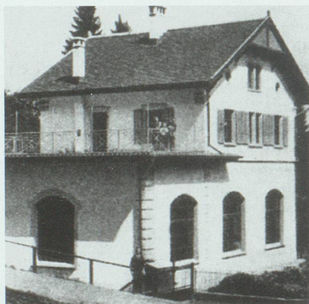
Das Maschinenhaus im Tobelägerli kurz nach dem Bau im Jahr 1902. Später wurden weitere Kraftwerke errichtet: 1928 im Altendorf, 1958 am Vorderberg, 1988 das neue Werk im Altendorf, 1998 die erste Solaranlage am Vorderberg ... Archiv EWB
