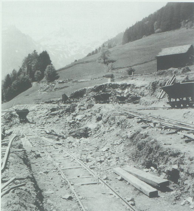
Die Ausbaurbeiten von 1942 dauerten vom 7. April bis zum 17. Dezember. Das Bild zeigt den Stand der Aushubarbeiten für den Ausgleichsweiher Vorderberg am 5. Juni 1942. Archiv Hansruedi Rohrer, Buchs
