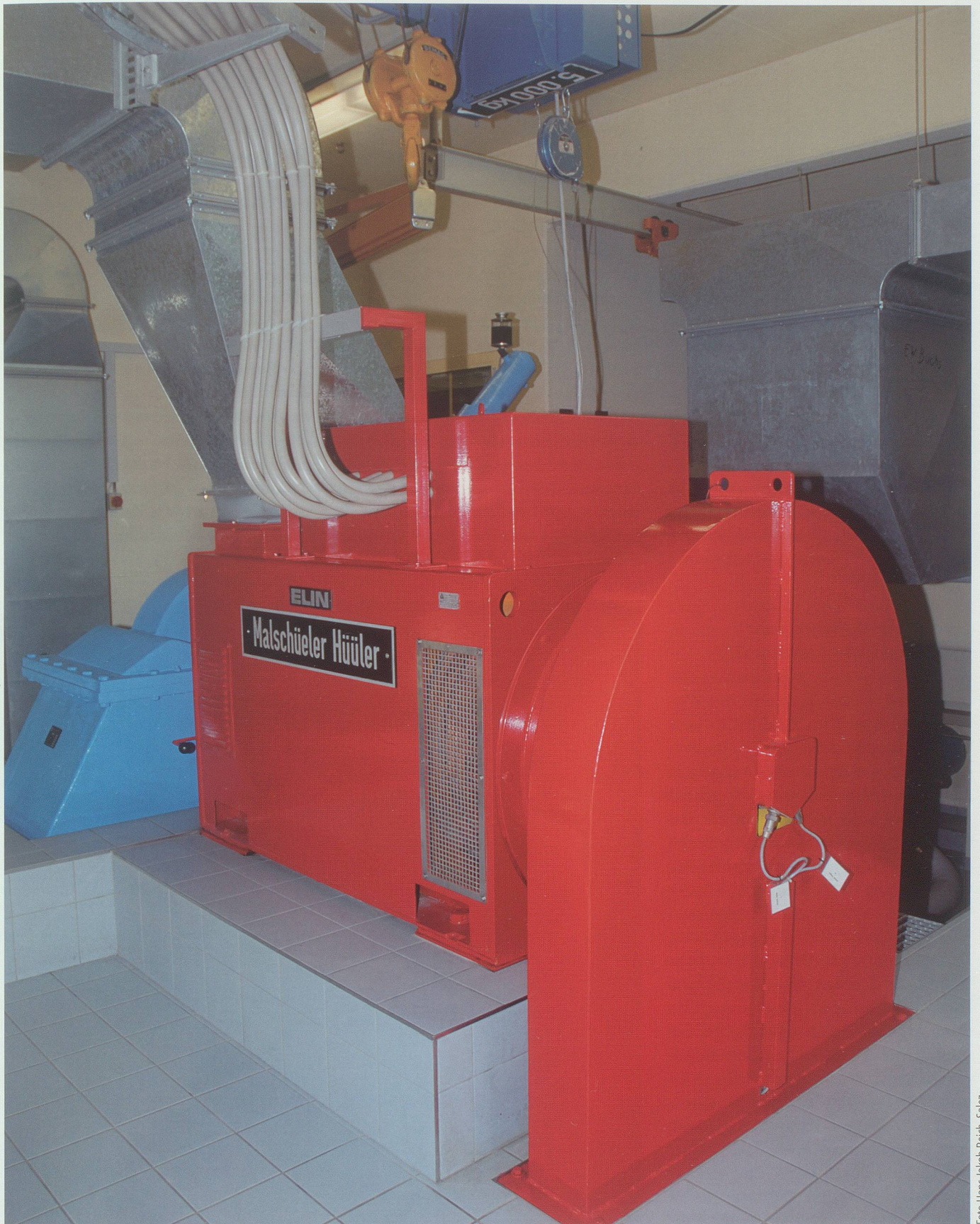
EWB-Kraftwerk Vorderberg/Buchs: 1000-kW-Synchrongenerator «Malschüeler Hüller».
