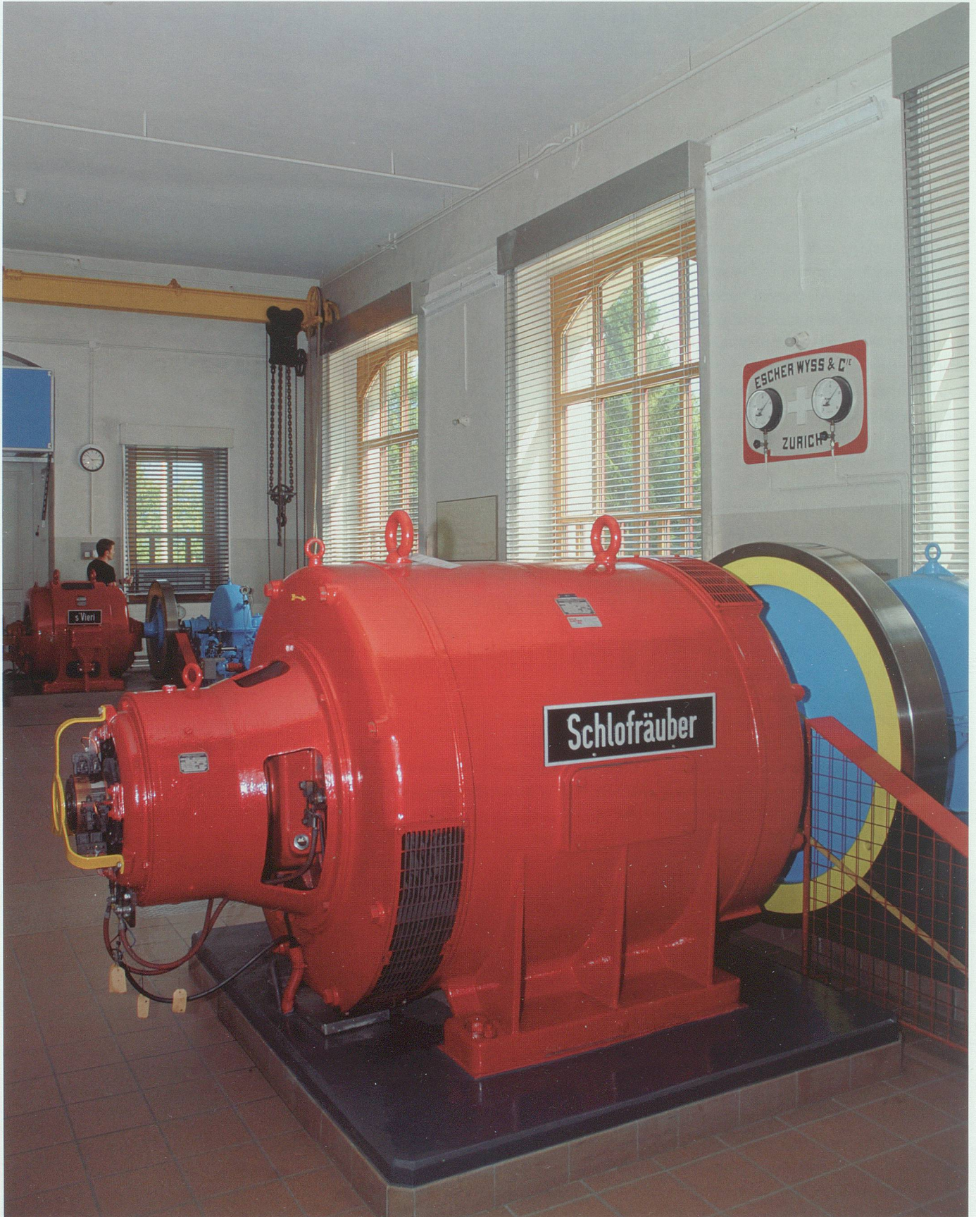
EWB-Maschinenhaus Tobelägerli/Buchs: Turbine Jahrgang 1951 («Schlofräuber») mit 736 kW installierter Leistung.
