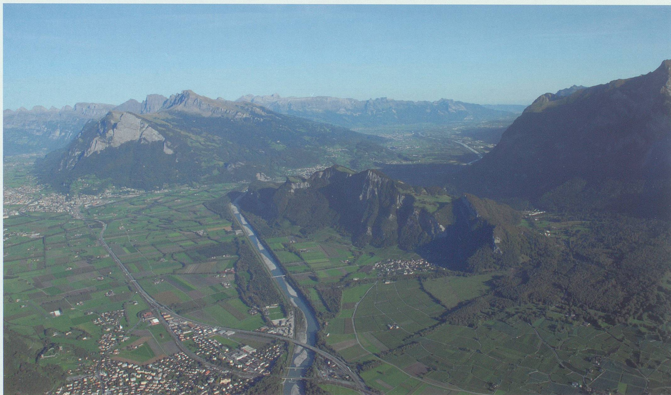
Der nördliche Abschnitt des Rheinwerke-Projektes von Ragaz (unten) bis zum Rheinknie am Ellhorn. Luftaufnahme 2006 Hans Jakob Reich, Salez
