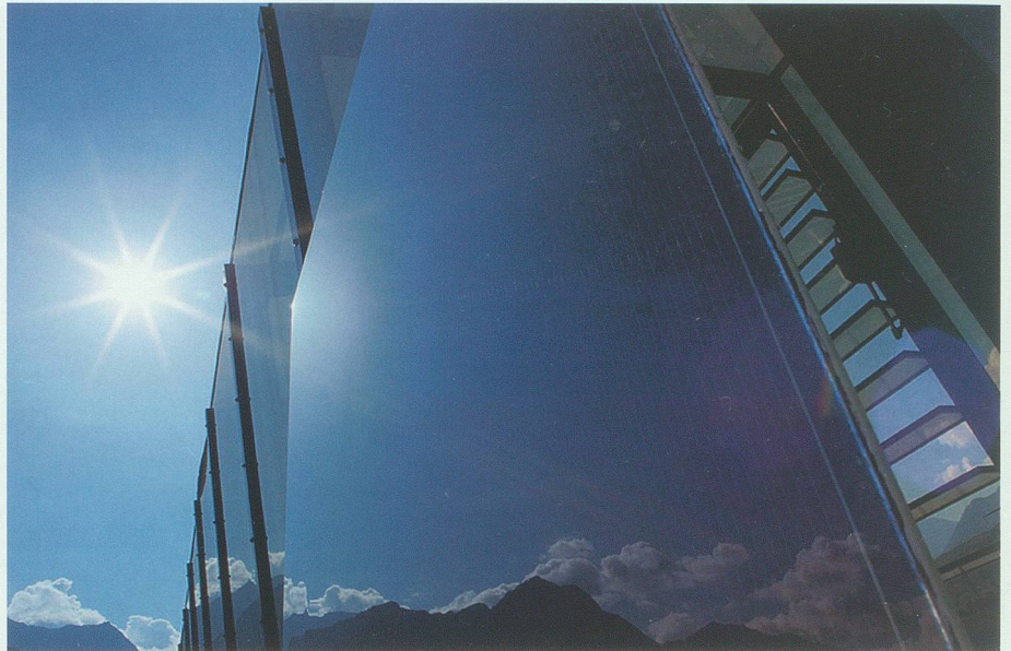
Dünnschichtsolarzellen, an deren Entwicklung Oerlikon Solar in Trübbach massgeblich beteiligt ist, öffnen der Photovoltaik neue Perspektiven. Foto Oerlikon Solar
