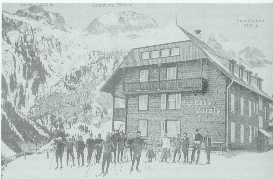
In den ersten Jahren wurde das 1908 als Luft- und Höhenkurort eröffnete Kurhaus Voralp auch für militärische Skikurse benutzt. Einen Teil der D pendance nutzte der Skiclub Grabs als Skih tte.
