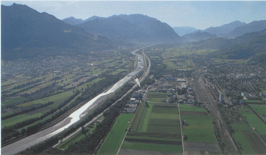
Für den Rhein ist es eng geworden. An sein einstiges Flussbett erinnern abschnittsweise noch die von der Autobahn durchschnittenen Galeriewälder. Luftaufnahme 2006 Hans Jakob Reich, Salez
