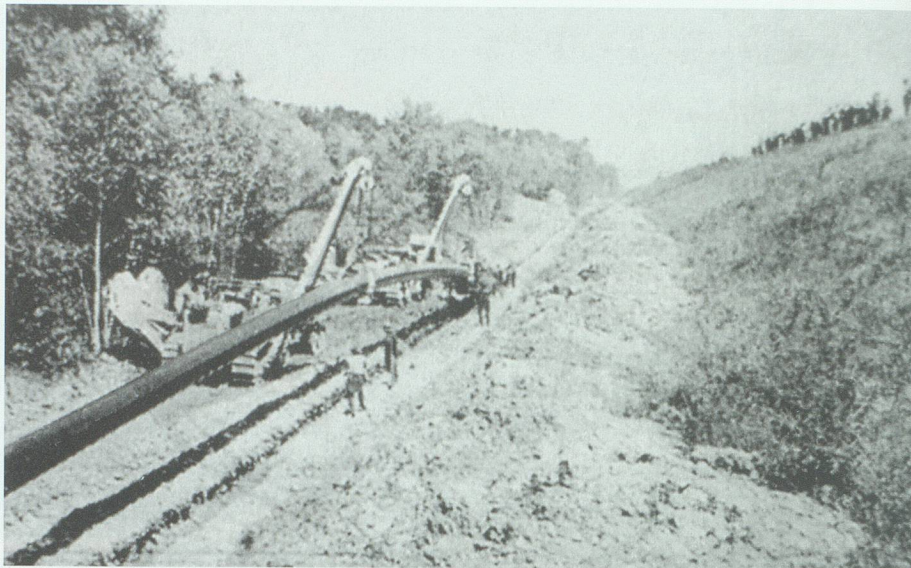
Für die von 1961 bis 1967 dem Rhein entlang verlegte Ölpipeline stellte der Kanton St.Gallen das Land kostenlos und ohne Rücksprache mit den Rheingemeinden zur Verfügung. Aus Hodel 2003, S. 174
