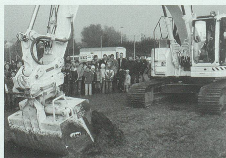
19. Oktober: Mit dem Spatenstich beginnen die Bauarbeiten für die Schul- und Sportraumerweiterung in Sevelen.
