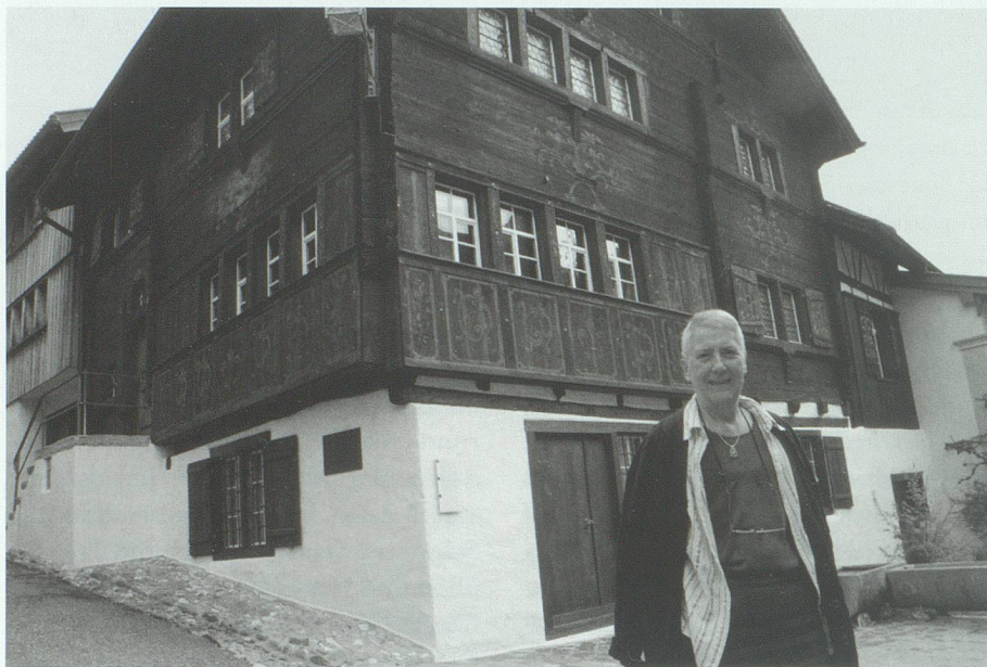
5. Januar: Das « Root Huus » von Draga Gantenbein im Städtchen Werdenberg erstrahlt nach einjähriger Fassadenrenovation in neuem Glanz.
