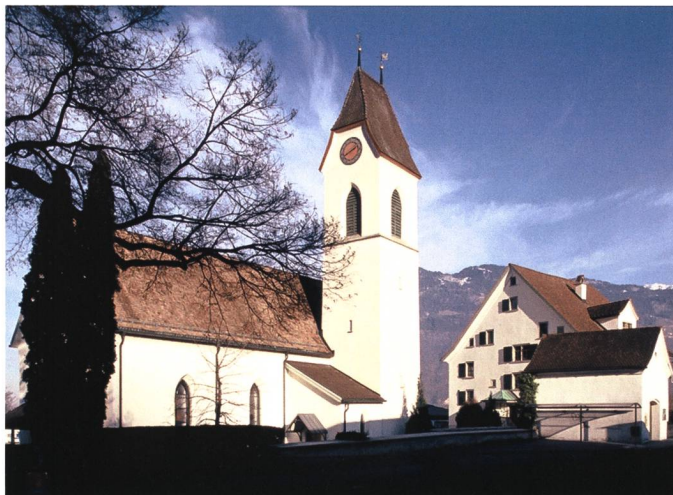
Kirchenbezirk Sevelen mit Beinhaus und Pfarrhaus. Foto Moritz Flury-Rova, kant. Denkmalpflege
