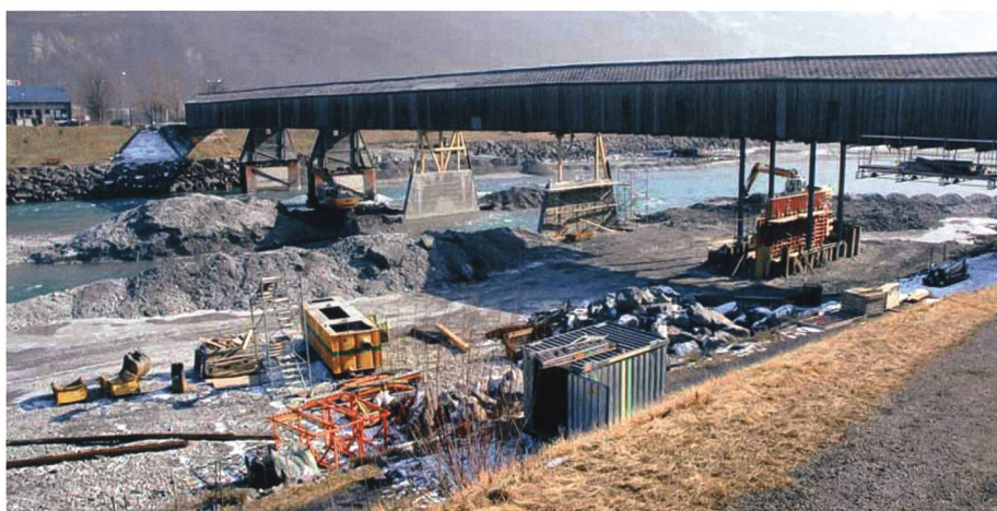
Besondere Bedingungen für die Sicherheit herrschten auf der Grossbaustelle im Rheintal im Winter 2008/9. Aus Broschüre 2011
