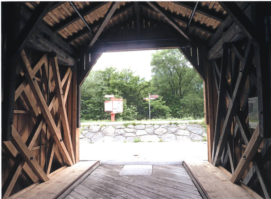
Der Blick aus dem Brückenkasten auf die Orientierungstafeln erinnert an die Funktion der Brücke im Langsamverkehr. Foto Otto Ackermann, Fontnas
