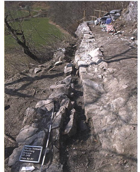
Abb. 20: Die nachträgliche Verbreiterung der Brüstungsmauer. Im Hintergrund verschwindet die Schollbergstrasse Richtung Hohwand und Sargans.
