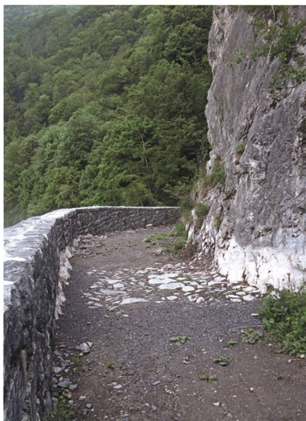
Abb. 9: Die Kurve unmittelbar nach der grossen Hohwand, Blick Richtung Sargans. Das Strassentrassee ist links durch eine Brüstungsmauer, rechts durch die Felswand begrenzt. Foto Maja Widmer, Sargans
