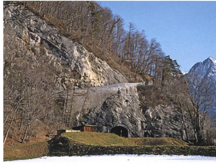
Abb. 6: Entlang der grossen Hohwand steigt die Strasse steil an.
