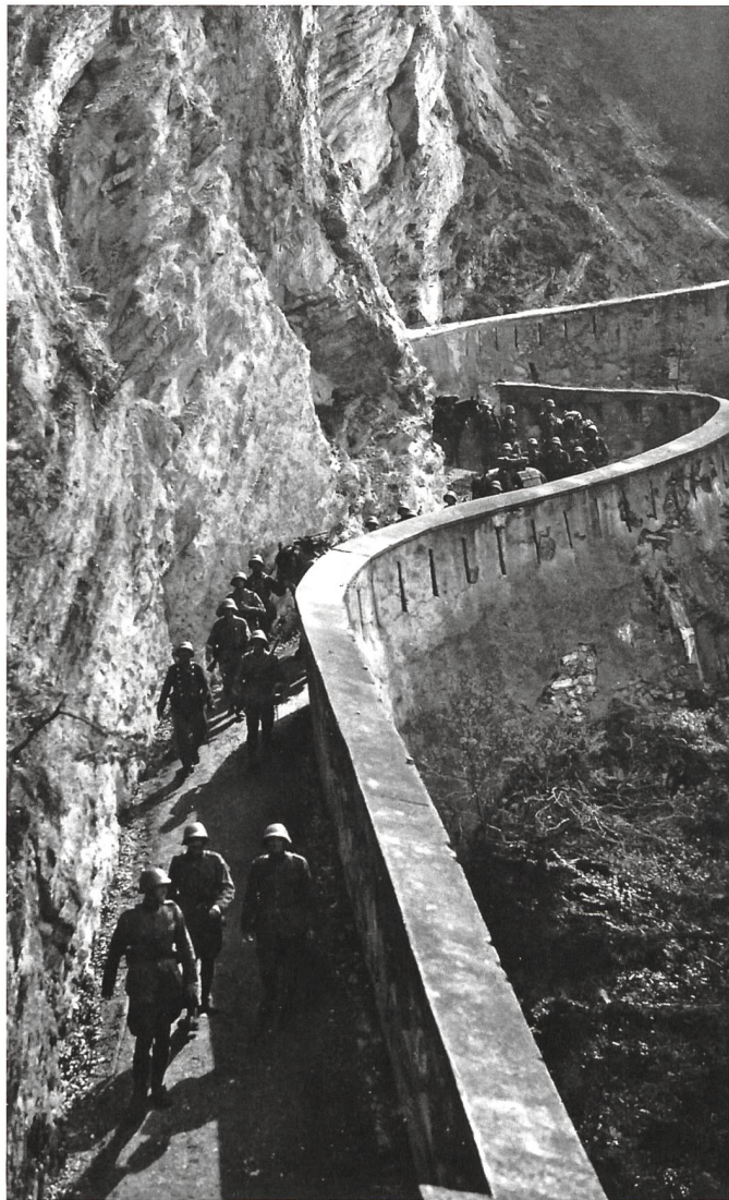
Die um 1850 gebaute Felsengalerie zwischen der Festung St.Luzisteig und den Blockhäusern (Bunkern) am Fläscher Berg. Postkarte aus den 1930er Jahren.
