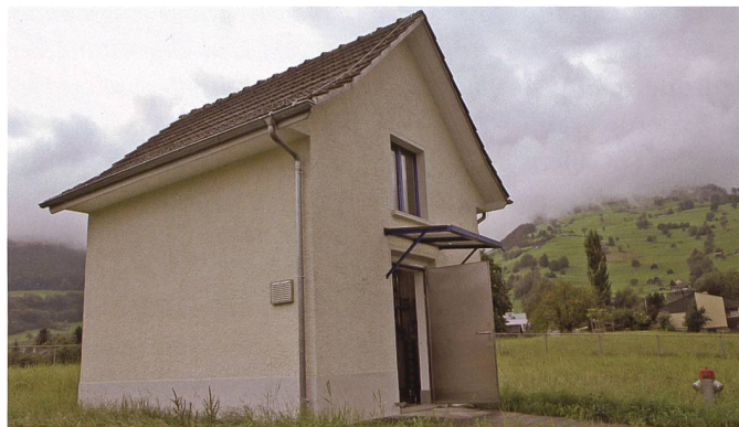
Ein typischer Vertreter der um die Mitte des 20. Jahrhunderts gebauten Grundwasserpumpwerke: das Pumpenhaus der Wasserversorgung Grabs am Studner Bach.
