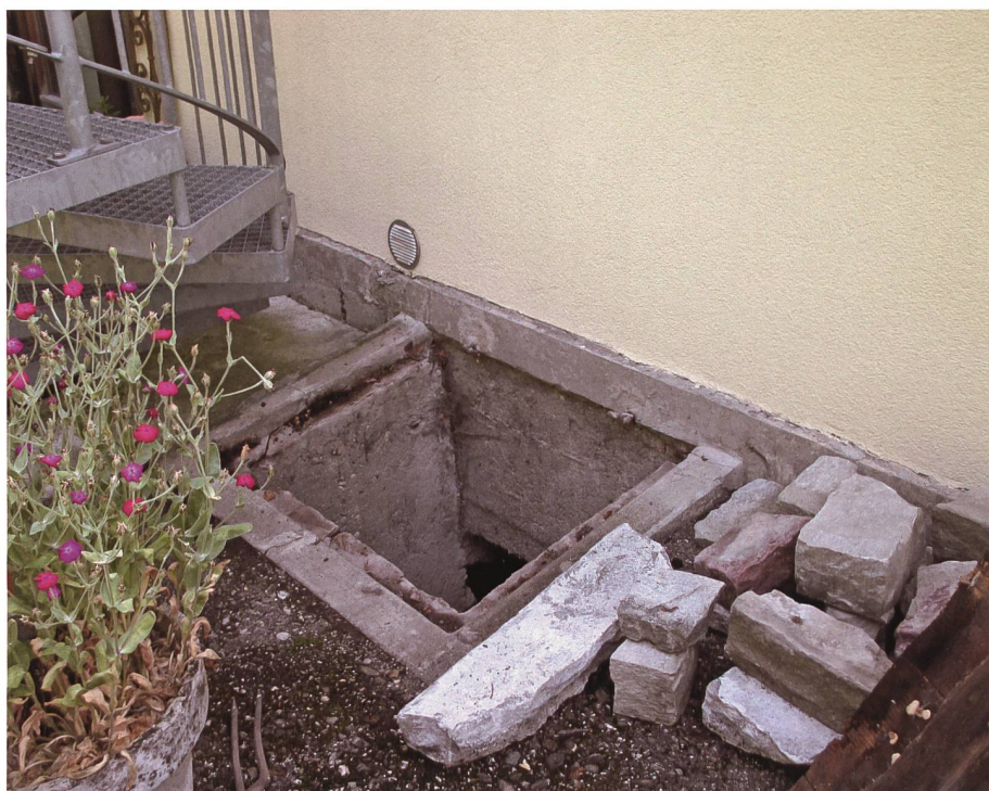
Die Reste des Zisternenbrunnens an der Chirchgass liegen versteckt an der Rückseite der Liegenschaft Torgler. Foto Werner Hagmann, Zürich
