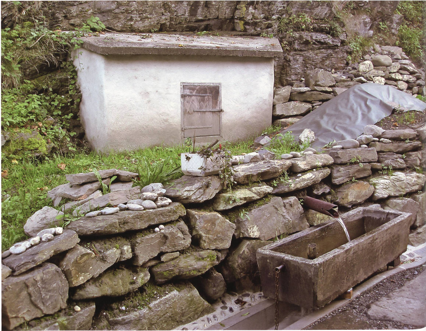
Die Brunnenstube der Hirschnerbrunnenquelle mit dem Überlauf. Foto Josef Gähwiler, Buchs
