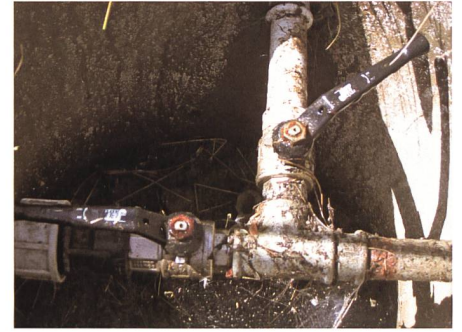
Verteilschacht beim Hüttler, Regulierung für Tränke und Zufluss zur Liegenschaft Feldmann im Guggi. Foto This Schwendener, Buchs
