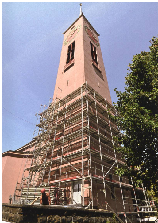
8. August: Dieser Tage wird der Buchser Kirchturm eingerüstet – die Fassade des 1931 erstellten Baus muss saniert werden.
