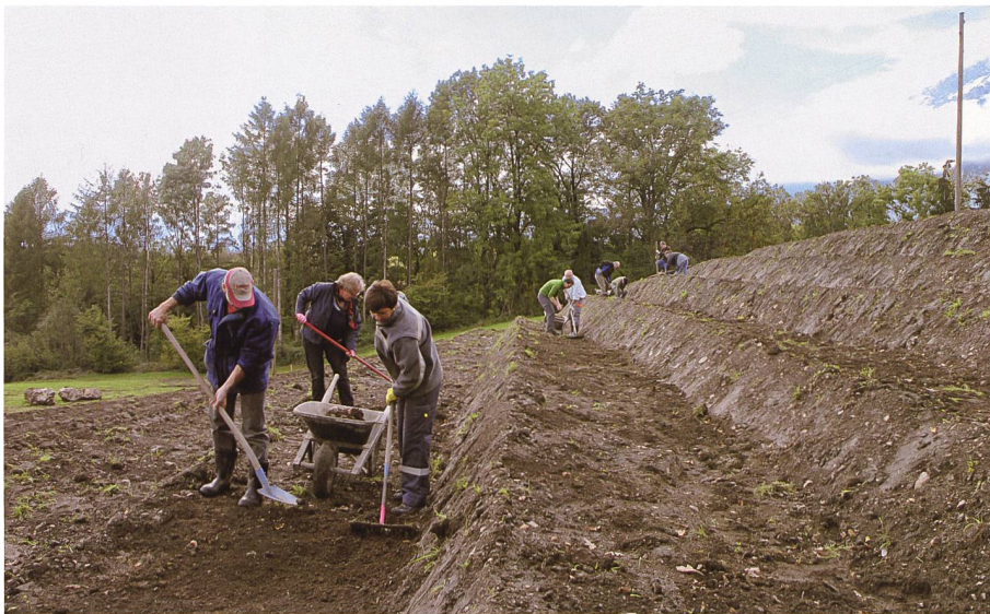
1. Oktober: Mit der Terrassierung mit Bagger und viel Handarbeit startet in Salez das Ökopjekt «Natur und Rebkultur».
