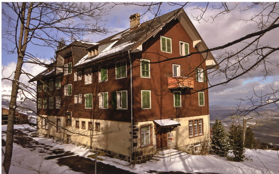
24. März: Die Buchser Ortsbürger beschliessen den Abbruch des Kurhauses Buchserberg zu Gunsten von Parkplätzen .
