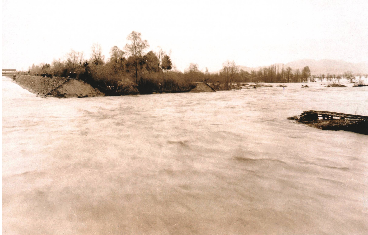
Die Dambruchstelle der Rheinkatastrophe vom 25. September 1927 bei Schaan.
