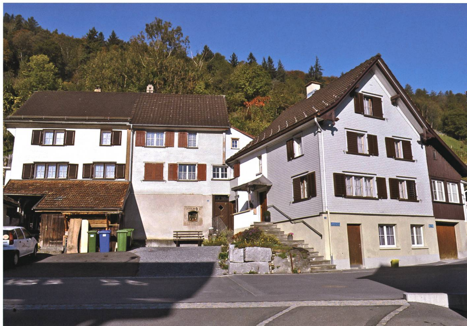
Gemäss mündlicher Überlieferung soll sich Peter Müller mit seiner Gattin Ursula, geborene Litscher, um 1802 in einem Teil des Doppelhauses (links) in Azmoos, das der verwitweten Judith (Weidmann-)Sulser gehörte, «haushäblich» niedergelassen und im Keller Geld gefunden haben. Foto Hansjakob Gabathuler, Buchs
