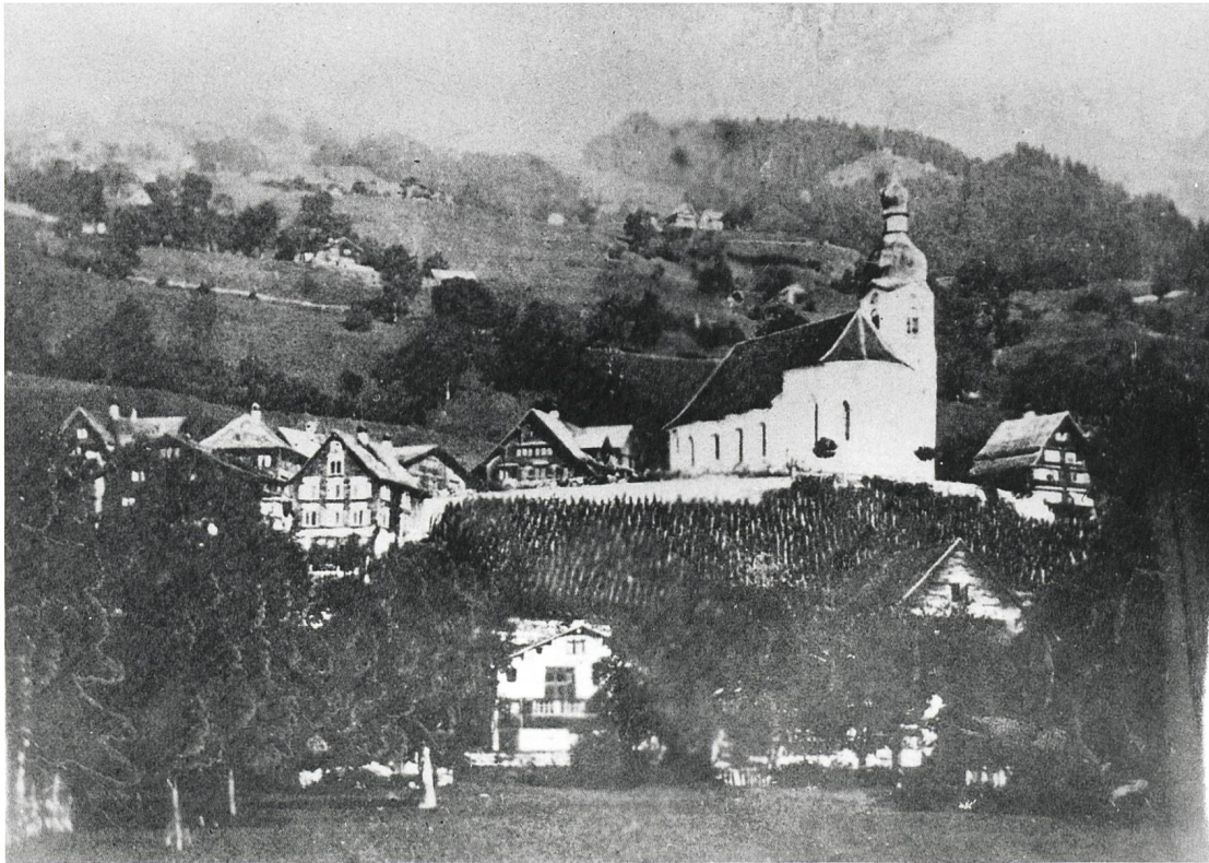
Die älteste erhaltene Ansicht der Michaelskirche von etwa 1860/70 dokumentiert neben dem mutmasslichen Chor Neubau um 1500 auch bauliche Eingriffe, die in das 18. Jahrhundert zu datieren sein dürften; hierzu zählen die stichbogigen Stürze der Kirchenschiffenster und die zwiebelförmige Turmhaube. Am westlichsten, höher sitzenden Fenster zeichnet sich die Schiffsverlängerung von etwa 1797 ab.
