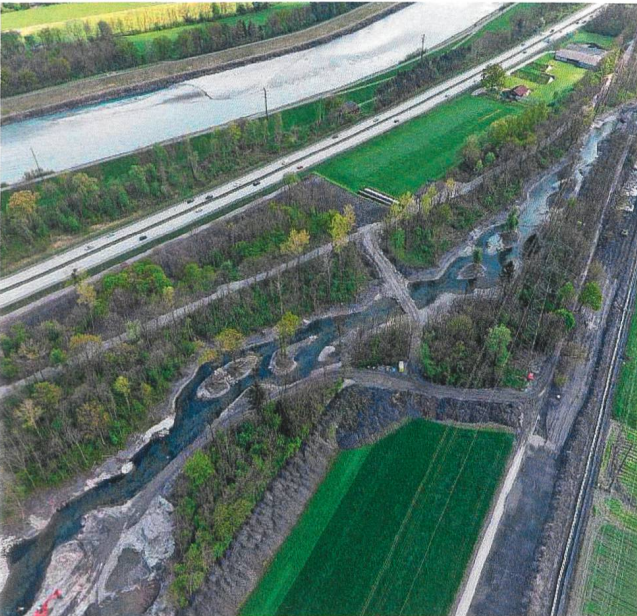
Luftaufnahme der Arbeiten, beide Bachläufe sind sichtbar.
