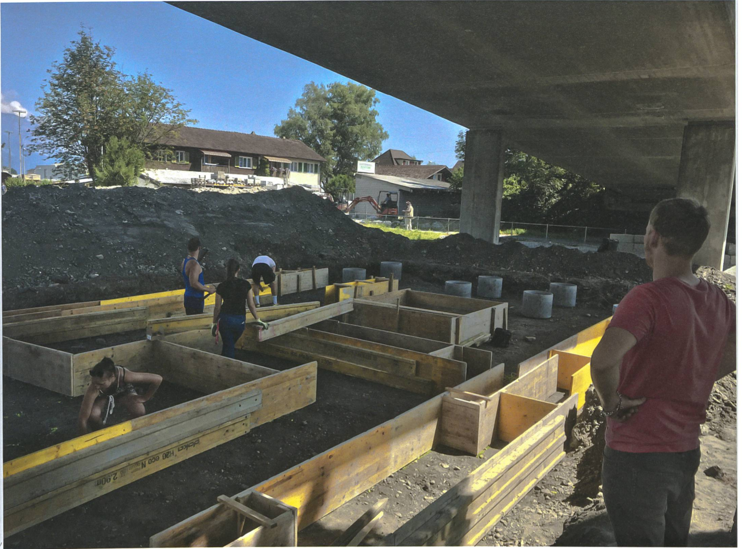
Jugendliche arbeiten am Fundament des Jugendparks Buchs.
