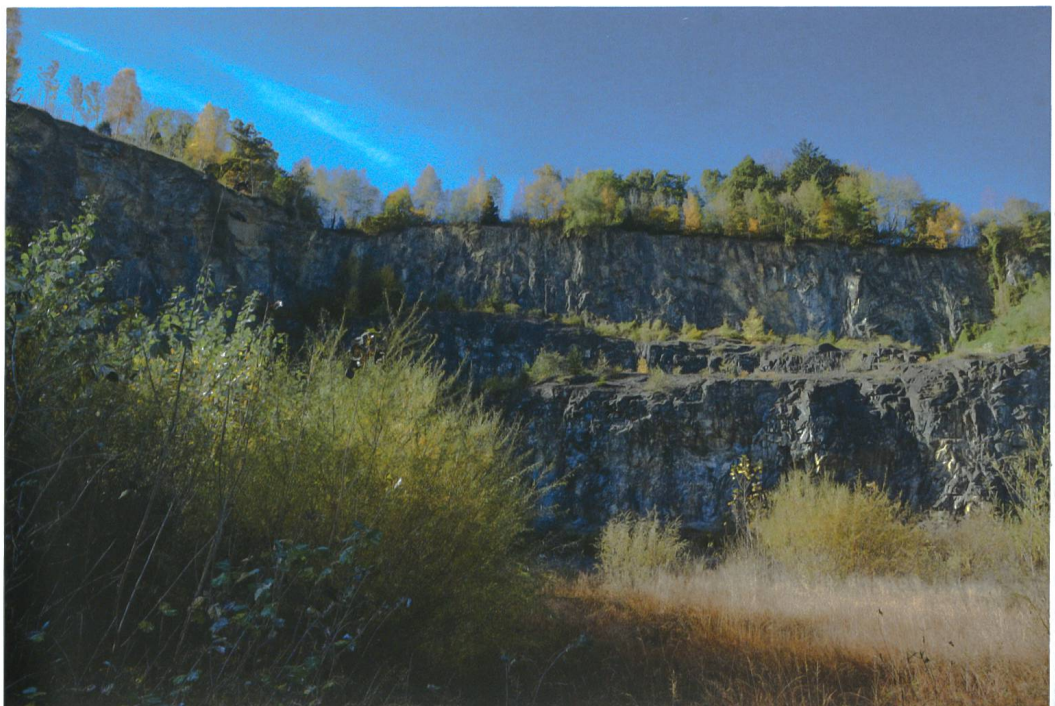
28.7.2018: Der Zugang zum Steinbruch Campiun musste aus Sicherheitsgründen verboten werden.
