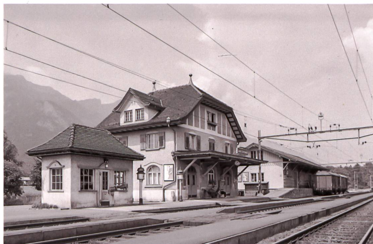
Das Stationsgebäude Salez-Sennwald um 1970.
