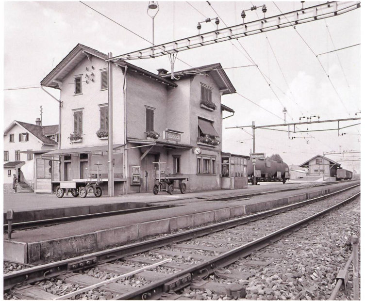
Das Stationsgebäude Trübbach, dem 1906 ein Wohngeschoss dazwischengesetzt wurde, im Jahr 1970.
