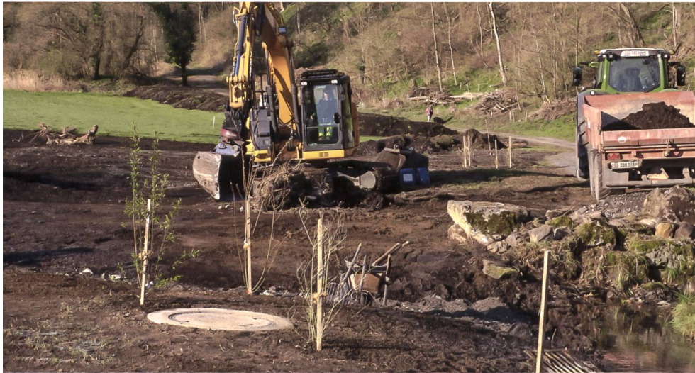
Für die Modellierung der Warm- und Kaltwasserzonen der Feuchtfläche wurden 1200 Kubikmeter Humus und Torf abgetragen und auf den benachbarten Feldern zur Bodenaufwertung ausgetragen. Lehmiges Material fand bei den Wasserflächen als Abdichtung Verwendung.
