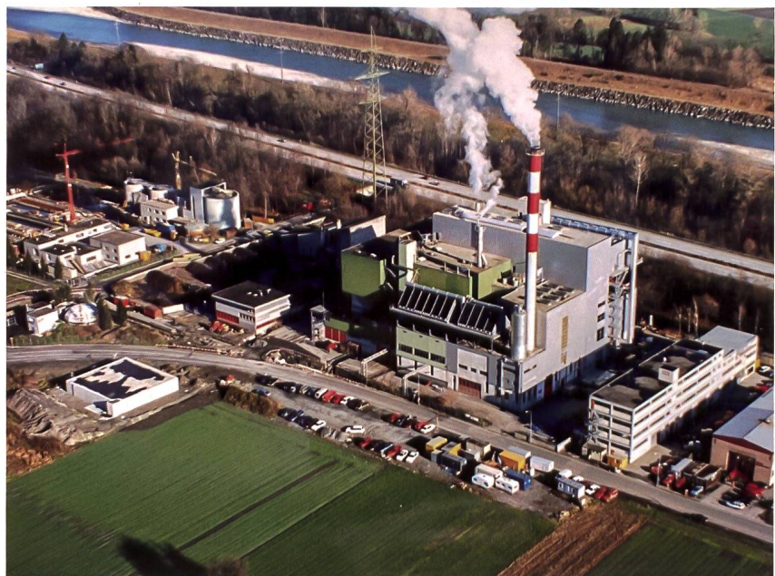
Die komplette Anlage nach dem Bau der Ofenlinie 3.
