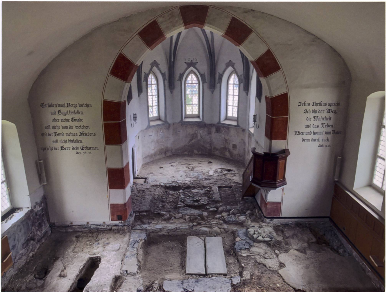
Sennwald, evangelische Kirche Sax. Übersicht über die Befunde in Chor und Schiff. Verschiedene ältere Böden und Bodenkonstruktionen sowie Einbauten (Altäre, Kanzel, Grabfelder) waren ausserordentlich gut erhalten.
