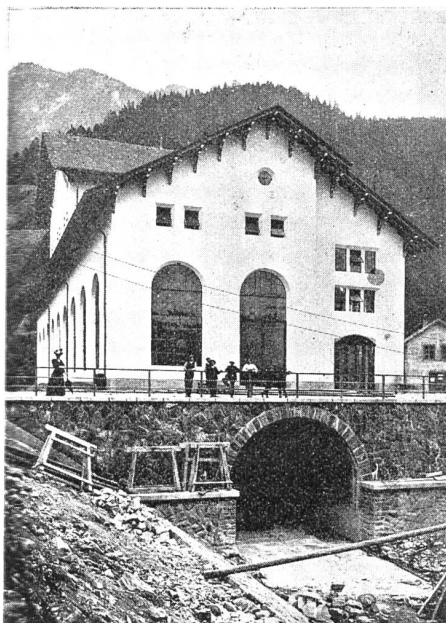
Abbildung 2. Maschinenhaus, Giebel gegen den Unterwasserkanal.
