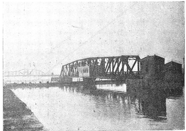
Abbildung 18. Schmetterlingtor (geschlossen). Chicago-Entwässerungskanal.
