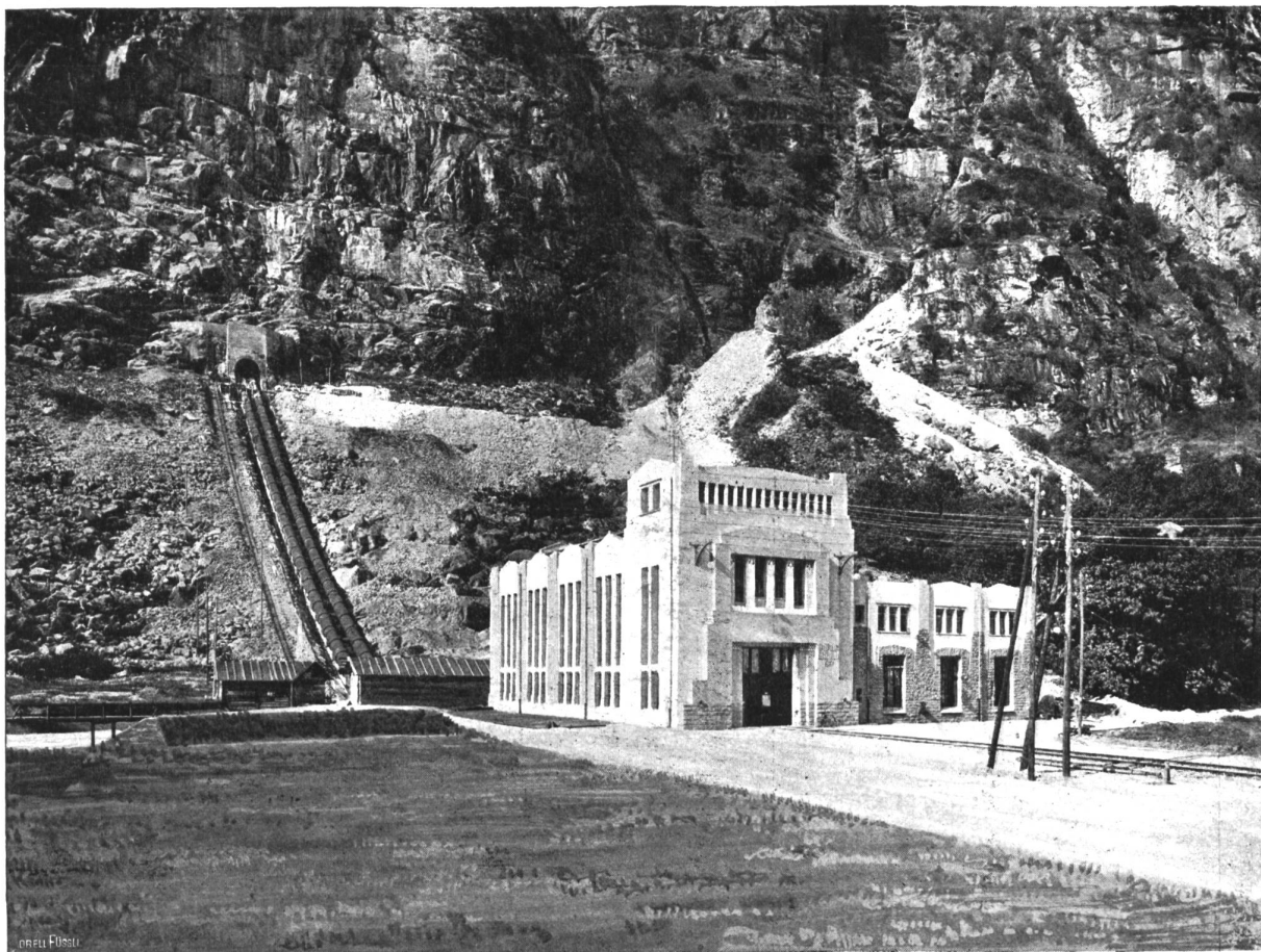
Abbildung 2. Maschinenhaus des Biaschinawerkes bei Bodio mit dem offenen Teile der Druckleitung.
