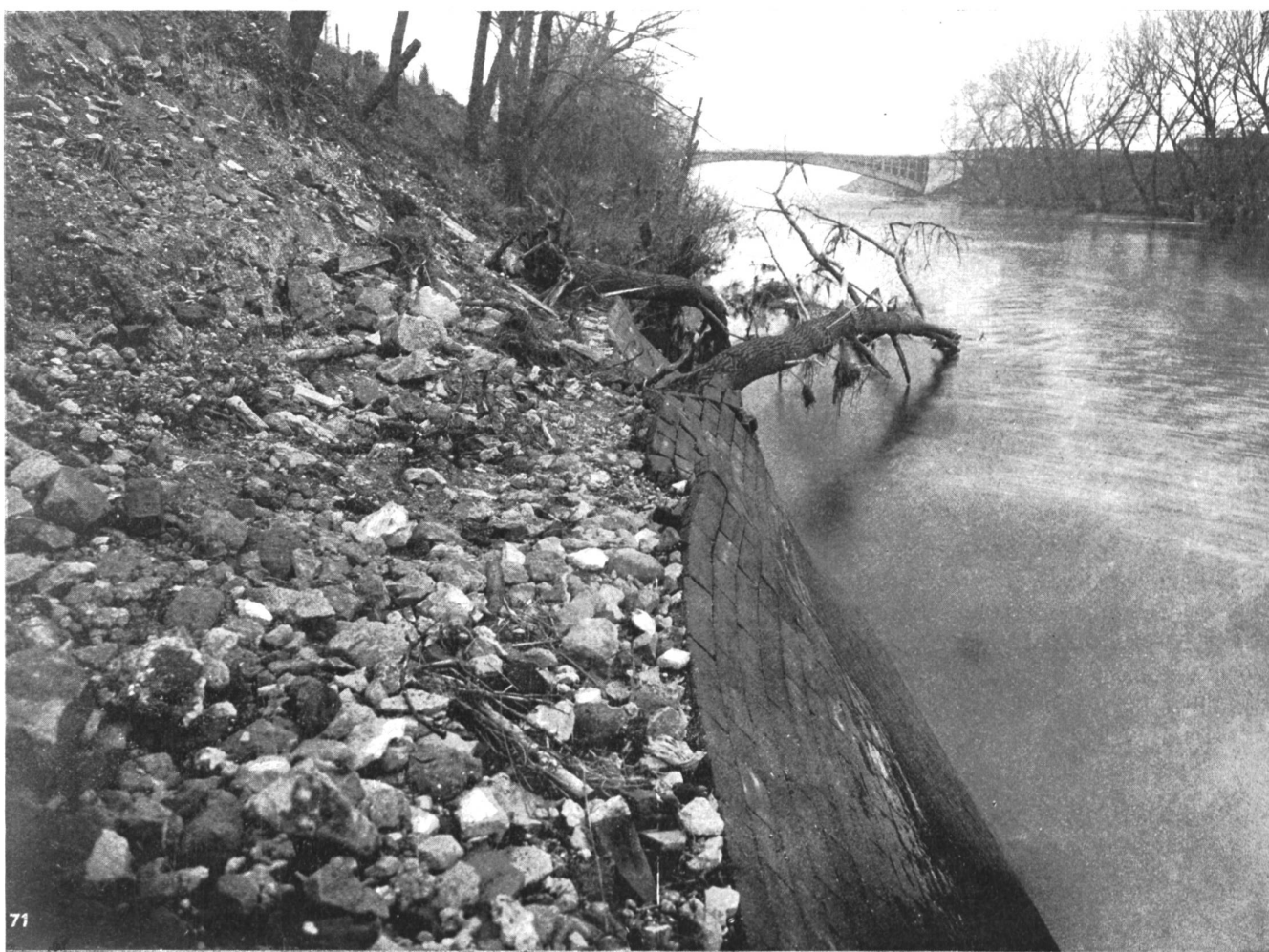
Le système Decauville et l'inondation de 1910 aux environs de Paris (Asnières). (Voir le texte.)
