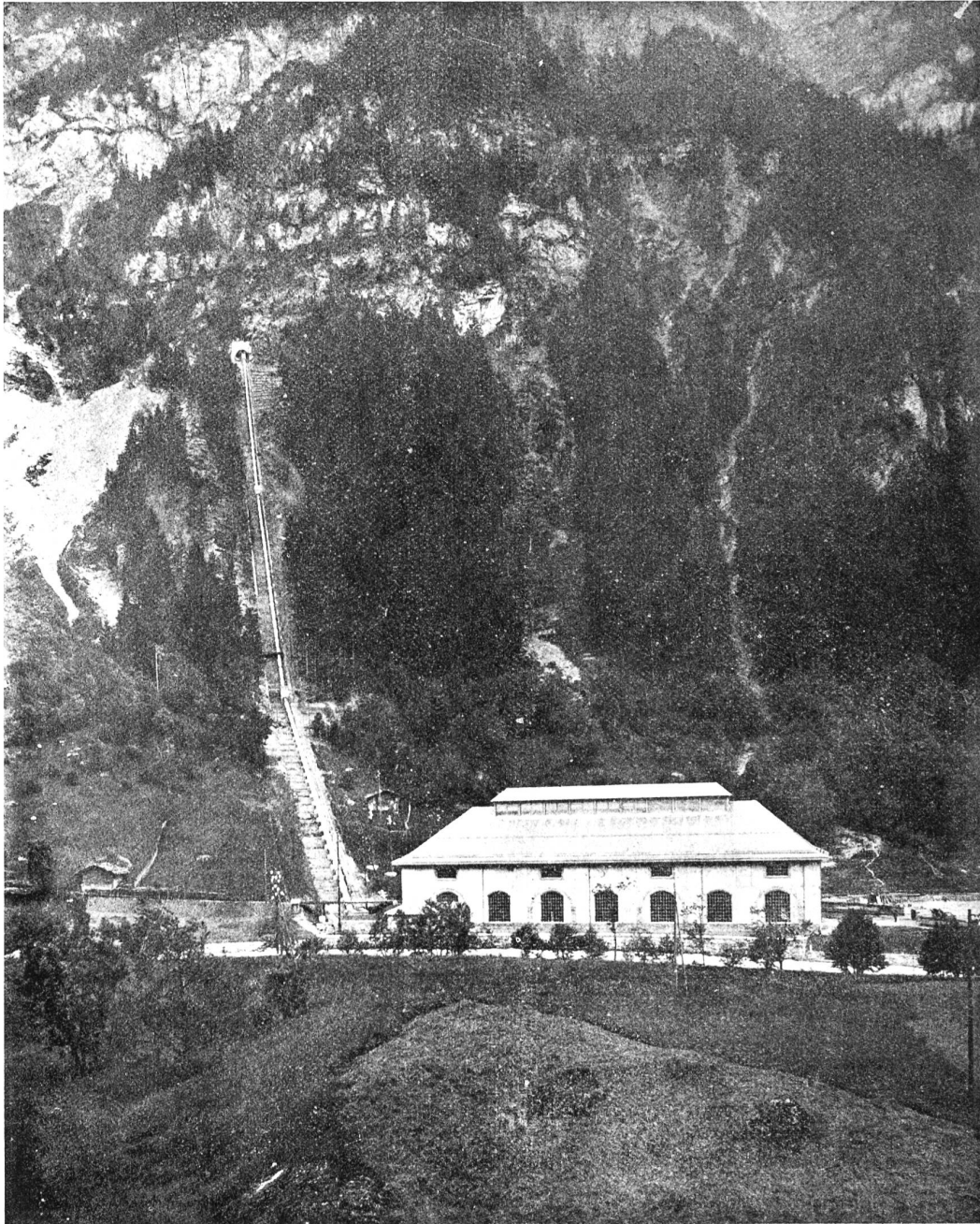
Abbildung 7. Elektrizitätswerk Kandergrund. Ansicht von Druckleitung und Maschinenhaus.
