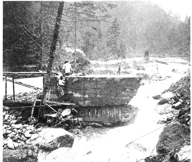
Das Alvierwerk. Abbildung 7. Das hinterspülte Stauwehr.
