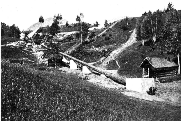
Das Alvierwerk. Abbildung 18. Fixpunkt F mit nach aufwärts im Bau befindlicher Rohrleitung.
