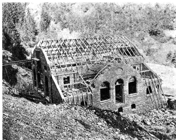
Das Alvierwerk. Abbildung 22. Das Turbinenhaus im Bau.
