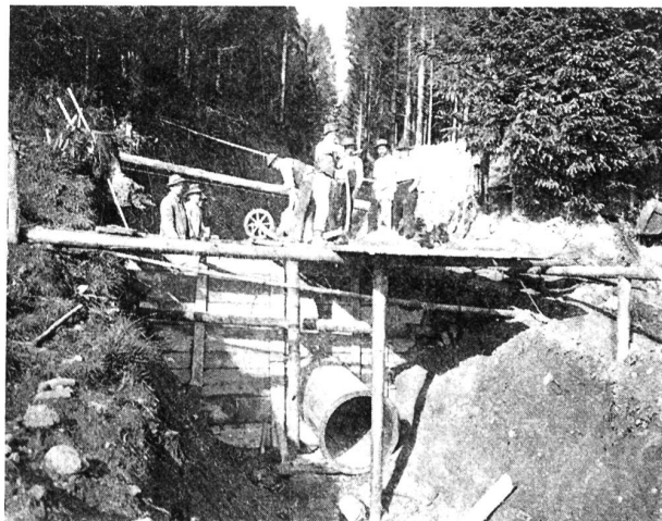
Das Alvierwerk. Abbildung 21. Einbetonieren eines Krümmers.
