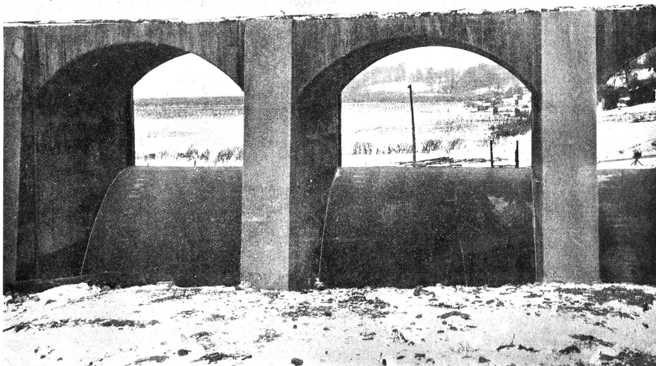
Die grösste Niederdruck-Wasserkraftanlage.
