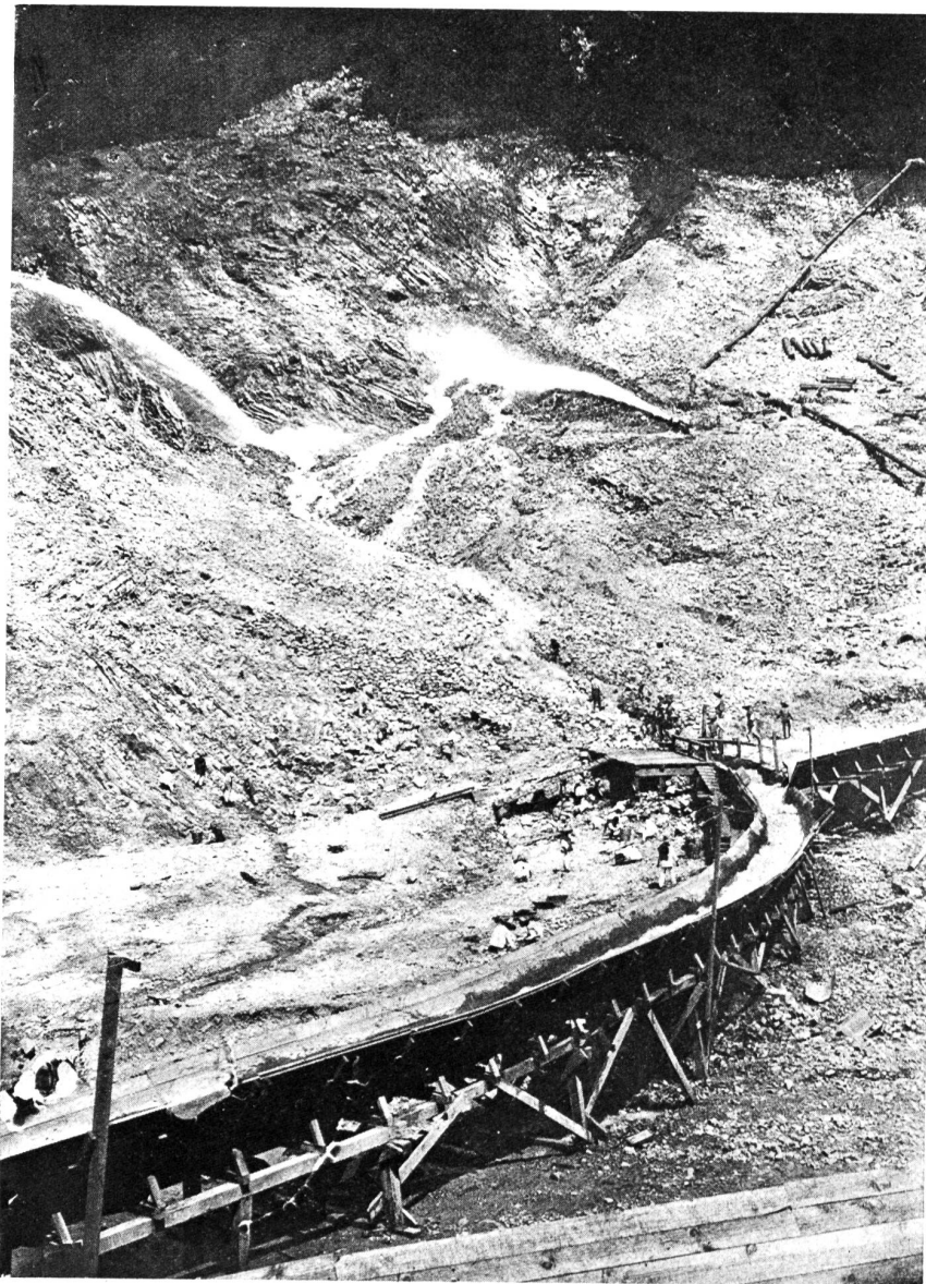
Der Necaxa-Damm. Figur 5. Schwemmen im Steinbruch und Einlauf eines offenen Kanals.
