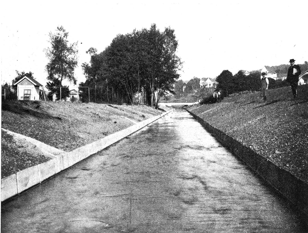
Uferschutzarbeiten. Abbildung 3. Birsig-Korrektion Oberwil (oberer Teil). Ausgeführt Sommer 1911.
