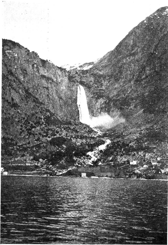
Abbildung 2. Feigum Kraftanlage. Sogn, Norwegen „Feigumfos“.
