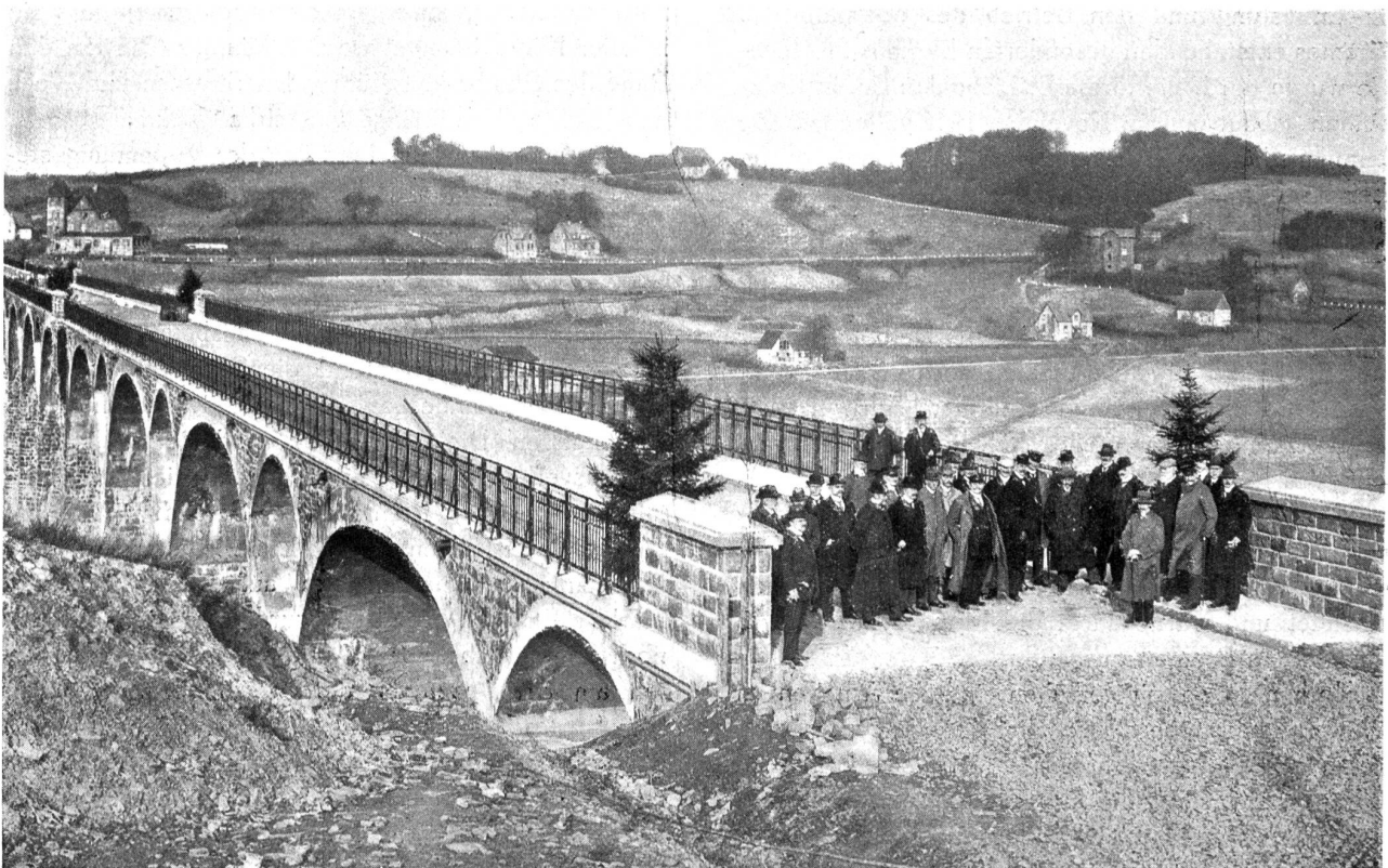
Möhnetalsperre. Abbildung 5. Viadukt bei Delecke am Tage der landespolizeilichen Abnahme.
